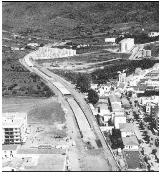
Figura 10.84. Obras de construcción del embovedado del río Monterroso en Estepona.
