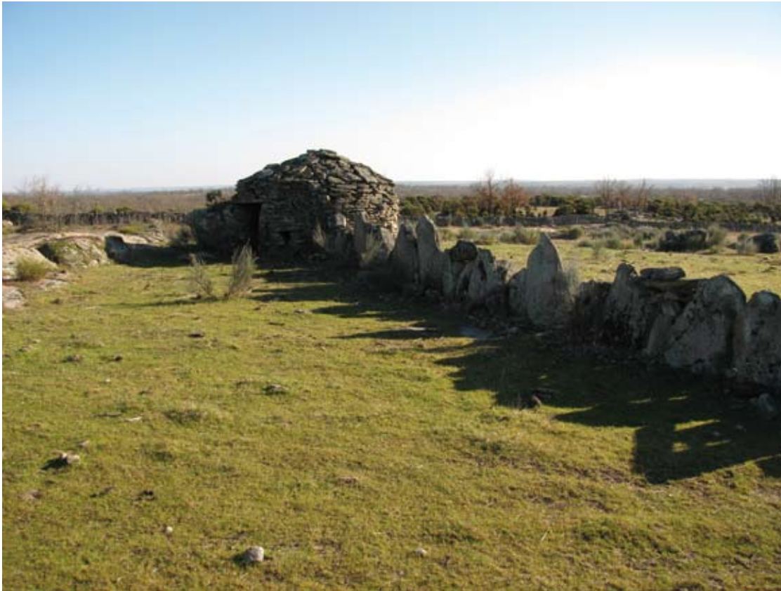
Un patrimonio construido disperso. Chozo y muros de piedra seca. La Vidola, Salamanca
