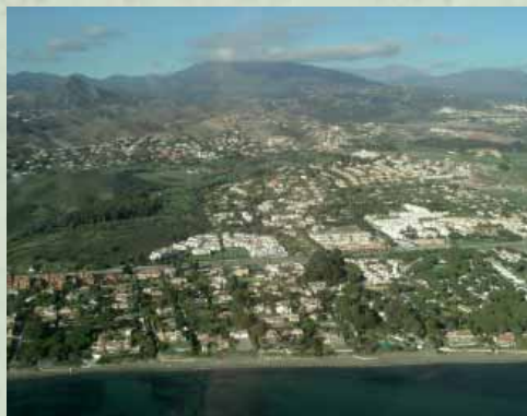
Figura 244. Numerosas urbanizaciones se construyeron antes de la Ley de Costas de 1988. Foto: J. Gómez Zotano.
