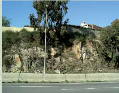
Figura 24. Trincheras en la A7 sobre las areniscas conocidas en el lugar como “pedernal”. Foto: J. Gómez Zotano.
