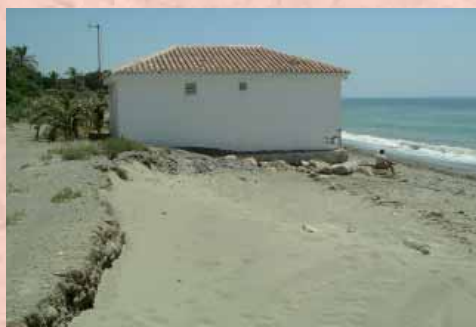
Figura 206. Las infraestructuras de saneamiento afean todo el litoral de Estepona. Foto: J. Gómez Zotano.
